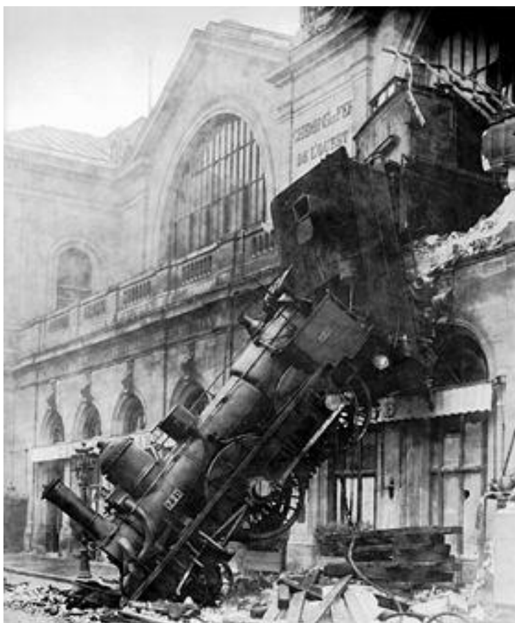
Рис. 9. Исторический снимок аварии на вокзале Монпарнас, когда поезд проскочил тупик и вылетел наружу.
